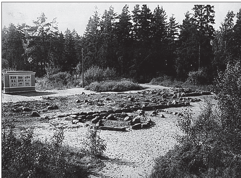
Рис. 3 Фундамент дома И.Е. Репина после расчистки парка (1945–1950-е). НИМ РАХ. Опубликовано на сайте: https://vk.com/smo_spbu?from=groups&w=wall-104459142_1146&z=photo-104459142_457240085%2Fwall-104459142_1146 (дата обращения: 24.08.2025)
