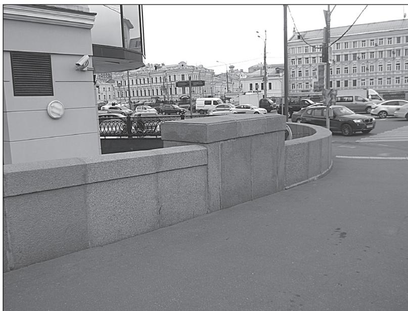
Рис. 2 Вид части Замоскворецкого подхода моста, выход к Балчугу. Блоки красного и серого гранитов, отделка цоколя лабрадоритом, 2016 г.
