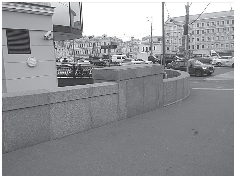
Рис. 2 Вид части Замоскворецкого подхода моста, выход к Балчугу. Блоки красного и серого гранитов, отделка цоколя лабрадоритом, 2016 г.
